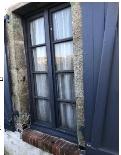
Fig. 2: Ouvertures, modénatures et volets bois conservés
